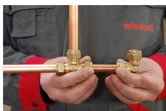
Fitting bis zum Anschlag auf das Rohr aufschieben und Überwurfmutter von Hand festziehen.
