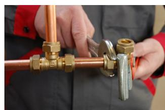
Überwurfmutter mit einem geeignetem Werkzeug wie z. B. einem Rollgabelschlüssel mit einem vorgegebenem Anzugsmoment gemäß nachstehender Tabelle festziehen. Zum Anziehen der Überwurfmutter dürfen keine Rohrzangen verwendet werden!
