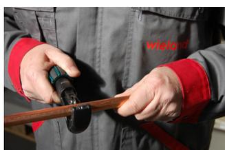
Metallrohre sind vorzugsweise mit einem Rohrabschneider, alternativ mit feinzahnigen Bügelsägen oder speziellen elektrischen Rohrsägen rechtwinklig abzulängen. Winkelschleifer oder Schneidbrenner dürfen zum Ablängen nicht verwendet werden.
