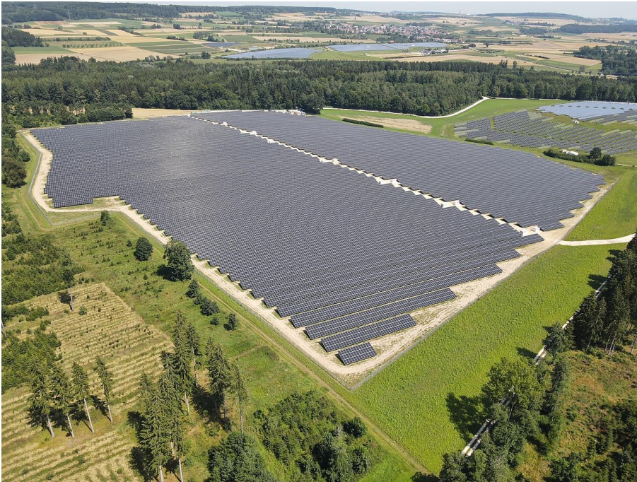
Drohnenaufnahme des 24 Hektar großen Wieland Solarparks in Erbach.
