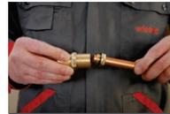
Übergangskupplung bis zum Anschlagpunkt in das geeignete Innengewinde einschrauben und handfest anziehen.
