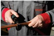
Metallrohre sind vorzugsweise mit einem Rohrschneider, alternativ mit feinzahnigen Bügelsägen oder speziellen elektrischen Rohrsägen rechteckig abzusägen. Winkelschneider oder Schneidbrenner dürfen zum Ablängen nicht verwendet werden.
