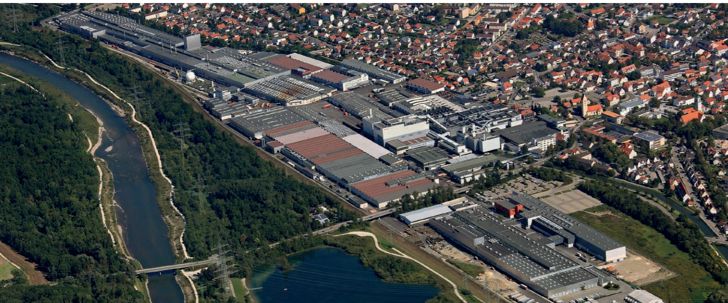
Usine Vöhringen - site de production de tubes d'installation en cuivre
